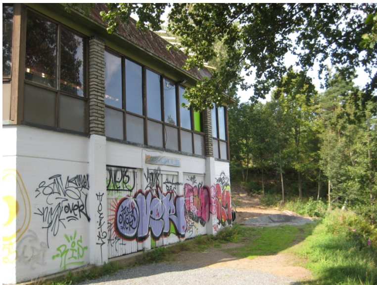
Bilde før utfyllingsarbeider.
