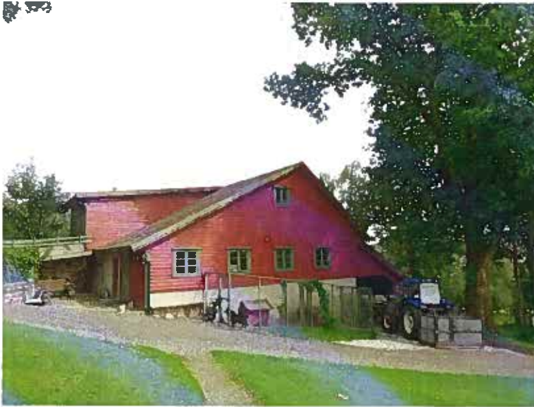
Aksnestunet sommeren 2013. Det nye toalettet er innenfor vindu nr to fra venstre, oppholdsrommet er innenfor de to vinduene til høyre.
