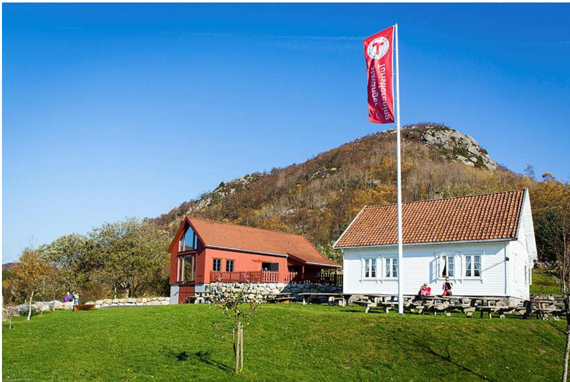
I 2016 stod Friluftslåven på Gramstad ferdig. Bygd med tanken på universell utforming er låven et perfekt sted for samlinger og aktiviteter for større grupper, og er godt tilrettelagt for rullestolbrukere. Området rundt byr på mange aktivitetsmuligheter. DNT Tilrettelagt har base her med utstyrslager og kontorplass, og arrangerer mange aktivitetsdager og -kvelder her. Foto: Marius Vervik
